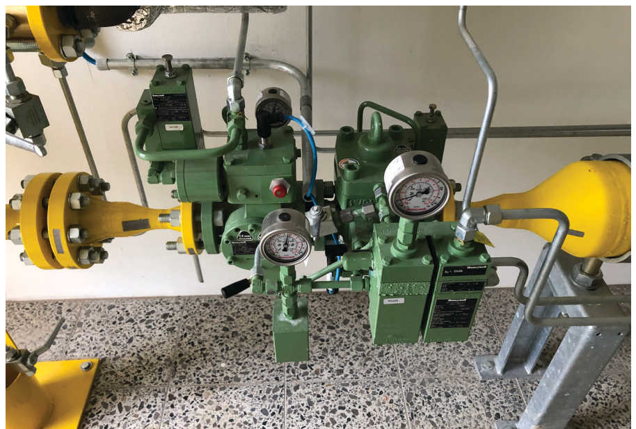
Gasdruckregelanlage „Witzwort“
