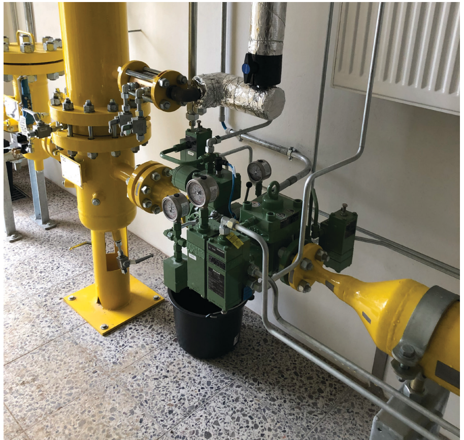
Gasdruckregelanlage „Wittenborn“
