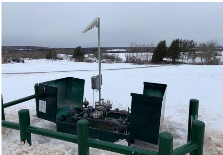
Installation eines elektronischen Mengenumwerters Mercury MiWi350 von Honeywell mit 4G-Modem und Solarpanel zur kontinuierlichen Überwachung in Kanada. Bildnachweis: CR Wall
